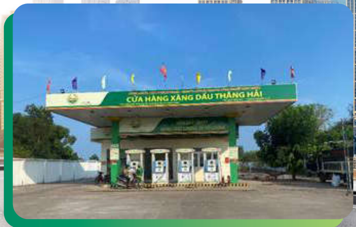
CỬA HÀNG XĂNG DẦU SỐ 39 - THẮNG HẢI QL 55, Thôn Thắng Hải, Xã Thắng Hải, Huyện Hàm Tân, Tỉnh Bình Thuận Diện tích: 1.439m 2 - Số trụ bơm: 4 trụ - Sức chứa: 50m 3
