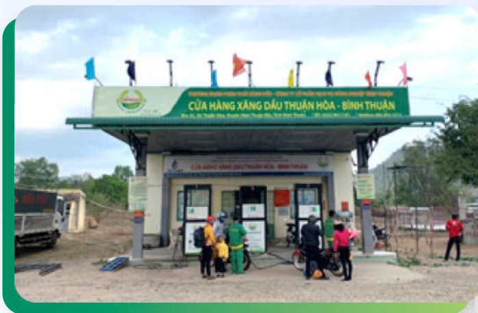
CỬA HÀNG XĂNG DẦU THUẬN HÒA BÌNH THUẬN QL 28, Thôn Dân Trí, Xã Thuận Hòa, Huyện Hàm Thuận Bắc, Tỉnh Bình Thuận Diện tích: 4.897m 2 - Số trụ bơm: 3 trụ - Sức chứa: 24m 3
