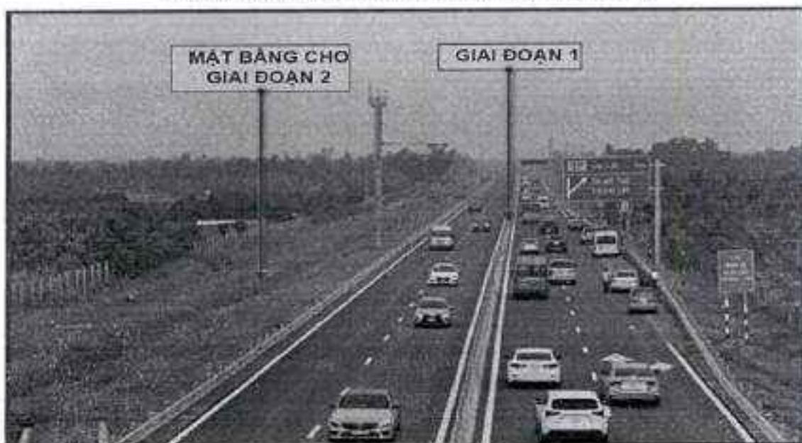
Hình 2: Hiện trạng đoạn Trung Lương – Mỹ Thuận
