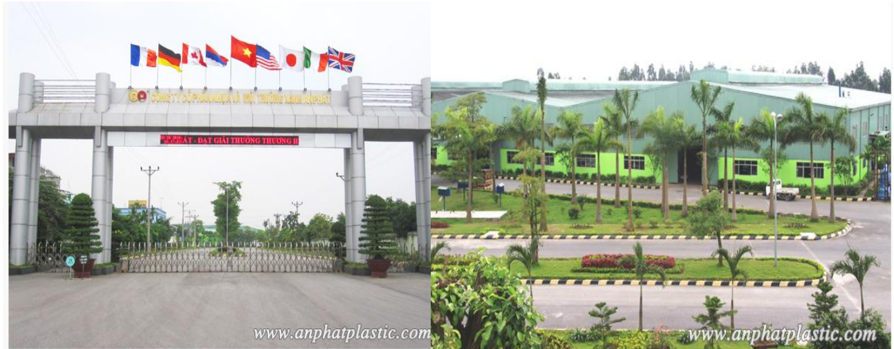
Hình 12: Một số hình ảnh về nhà máy
