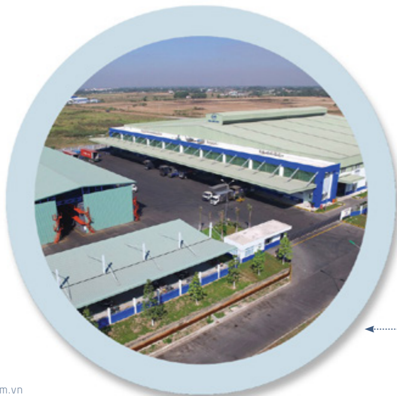
NHÀ MÁY LONG AN
