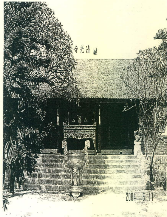
Công trình chùa Thanh Quang
