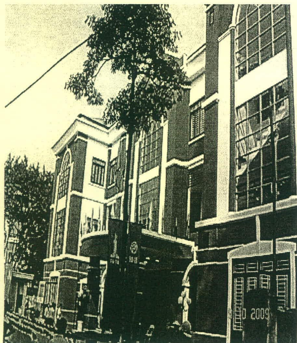
Công trình UBND Phường Khương Mai
