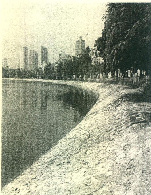
Công trình cải tạo Hồ Hào Nam- Đống Đa
