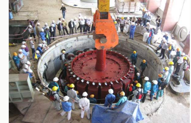
Hạ Roto tổ máy số 1
