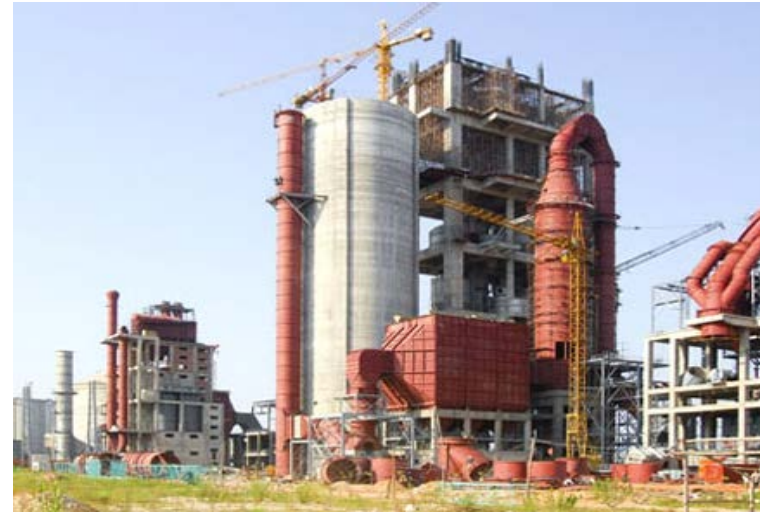
Hệ thống cyclon 5 tầng trao đổi nhiệt và buồng phân hủy
