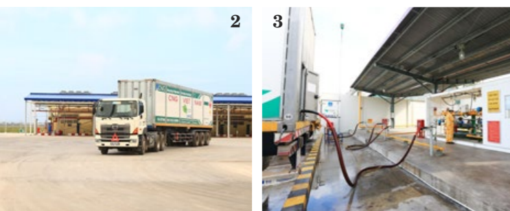
Tại thị trường miền Bắc, nhận nguồn khí từ mỏ Hàm Rồng và Thái Bình, xử lý khí tại Nhà máy của PV GAS (1) qua đường ống của PVGAS D, CNG Việt Nam vận chuyển bằng xe chuyên dụng (2) đến các trạm giảm áp PRU đặt tại khách hàng (3).
