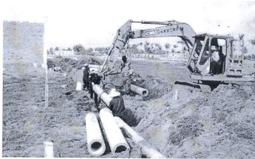
Hình 3: Thi công hệ thống thoát nước của Công ty Cổ phần Cấp thoát nước Cần Thơ
