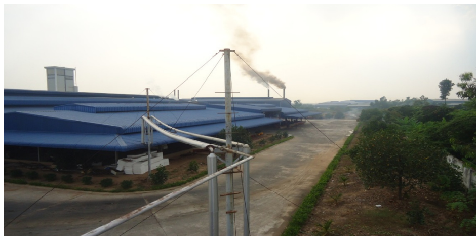
Hình 6: Hình ảnh một số máy móc thiết bị chính của Nhà máy bột cá/mỡ cá
