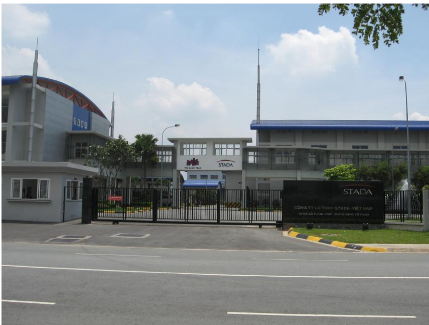
Hình ảnh công trình nhà máy Stada
