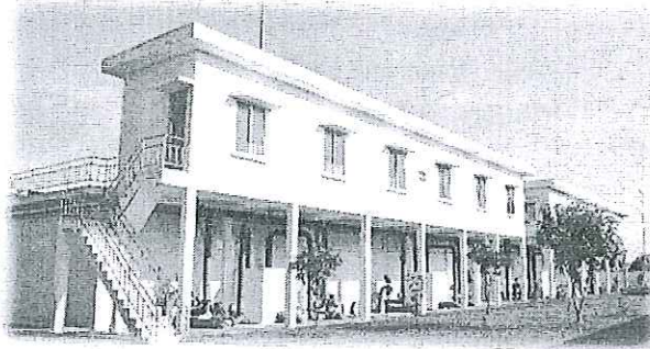
Nhà máy nước Cà Giang
