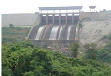
Nhà máy thủy điện H'Mun
