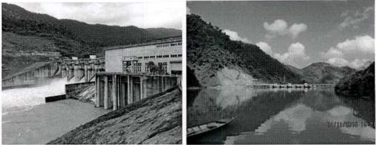
Hình 6: Một số hình ảnh về dự án thủy điện Sông Bung 4A
