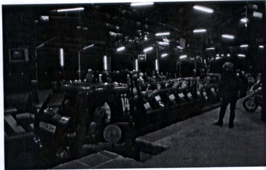
Hình ảnh về hoạt động khai thác kinh doanh tại hầm đường bộ Hải Vân của Hamadeco
