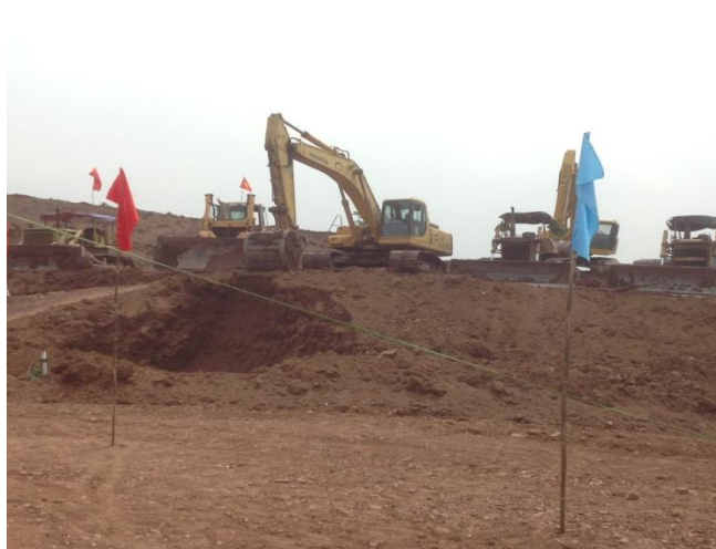
Thi công dự án gạch Hòa Long
