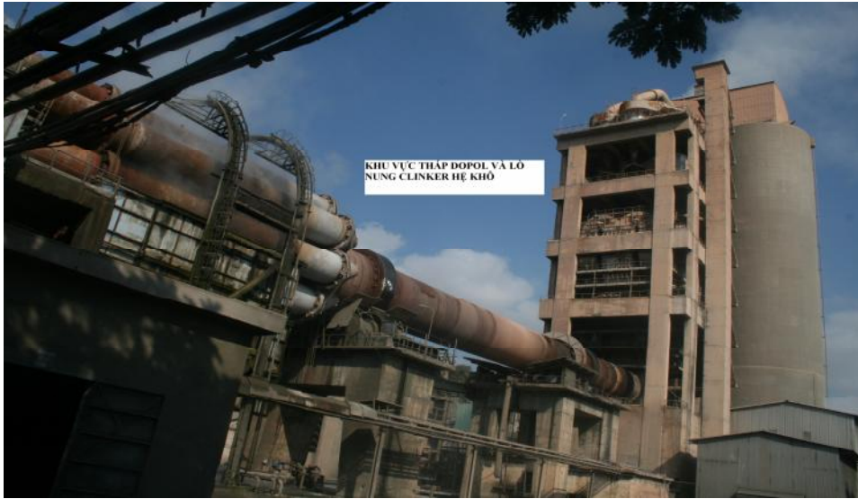
H th ng tháp trao i nhi t và lò nung Clinker h khô
