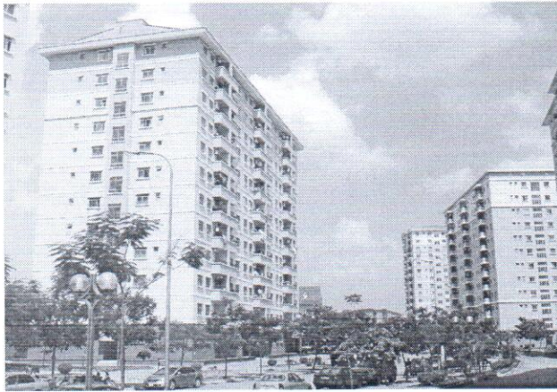
Công trình: Nhà CT3C - X2 Bắc Linh Đàm - Hà Nội Khởi công: Tháng 10/2004 Hoàn thành: Tháng 02/2006 Giá trị xây lắp: 21.000.000.000 đồng
