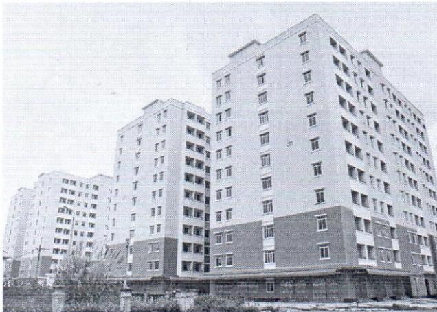
Công trình: Khu NOXH phường Phú Sơn - TPTH Khởi công: Tháng 12/2009 Hoàn thành GĐI: Tháng 12/2011 Giá trị xây lắp: 320.000.000.000 đồng
