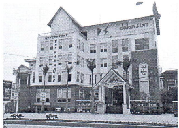
Công trình: Nhà hàng Dạ Lan II - TP Thanh Hóa Khởi công: Tháng 12/2008 Hoàn thành: Tháng 4/2011 Giá trị xây lắp: 13.187.000.000 VNĐ
