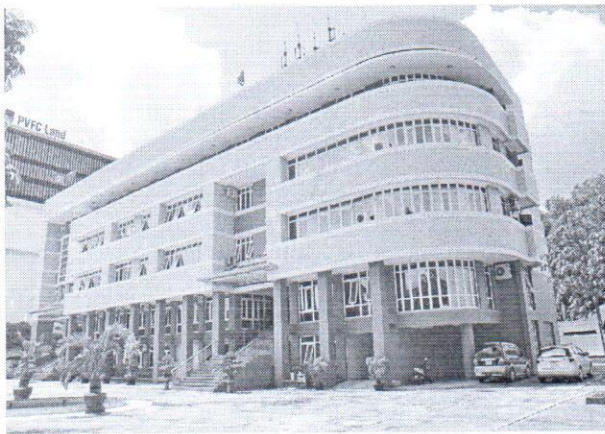
Công trình: Tr.sở liên CQ Sở Tư pháp-TT&TT T.Hóa Khởi công: Tháng 12 năm 2007 Hoàn thành: Tháng 12 năm 2008 Giá trị xây lắp: 18.900.000.000 VNĐ Công trình được chứng nhận đạt Chất lượng cao
