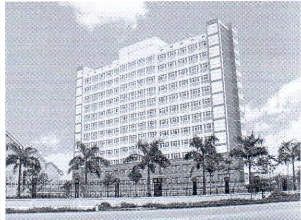
Công trình: Khu nhà ở Sinh viên 13 tầng - TPTH Khởi công: Tháng 01/2010 Hoàn thành: Tháng 01/2012 Giá trị xây lắp: 72.000.000.000 VNĐ
