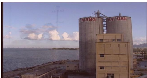
Hình ảnh về nhà máy sản xuất xi măng
