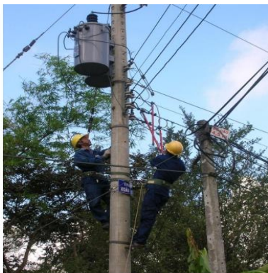
Hình 6: Hình ảnh hoạt động lắp đặt hệ thống điện
