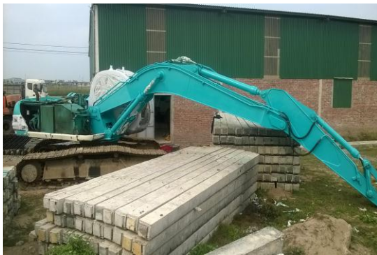
Cọc bê tông thành phẩm
