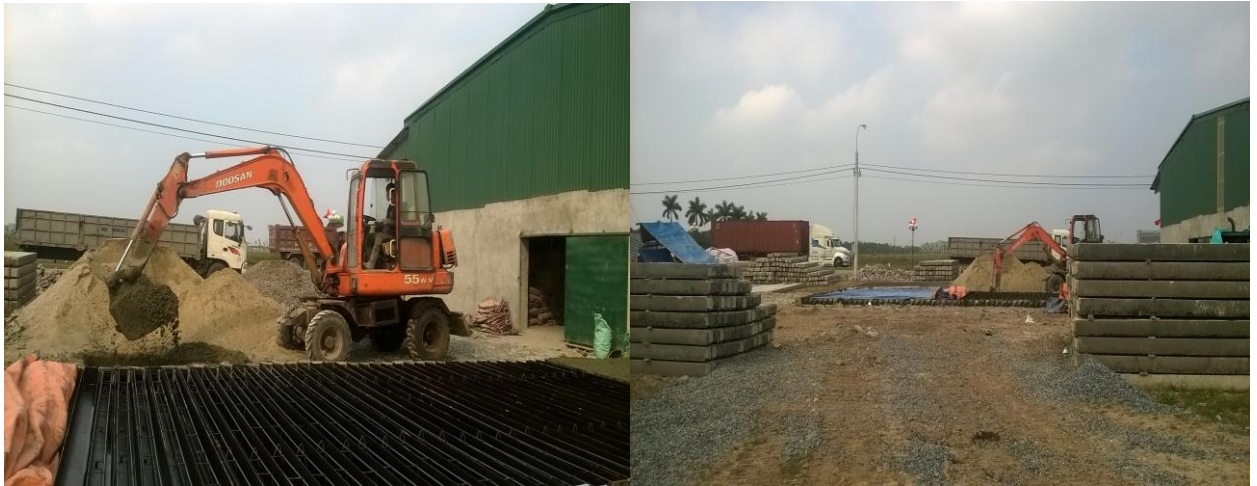
Xưởng cộc và đúc cộc bê tông
