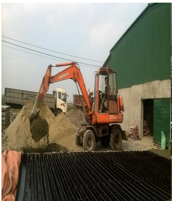
KHUÔN ĐÚC CỌC BÊ TÔNG
