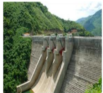
Công trình Nhà máy thủy điện A Vương
