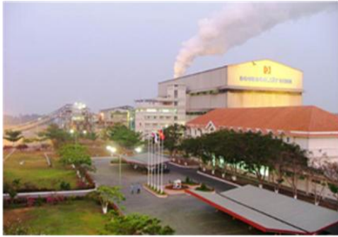
Nhà máy Đường Bourbon Tây Ninh
