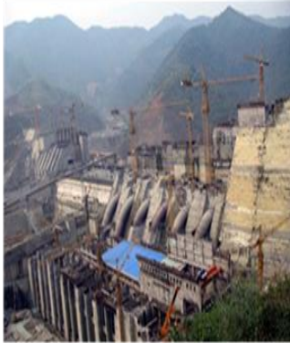
Công trình Nhà máy thủy điện Sơn La
