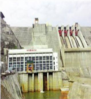
Công trình Nhà máy thủy điện Bản Chát
