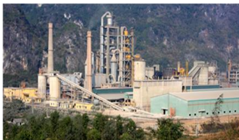
Nhà máy Xi măng La Hiến – Thái Nguyên
