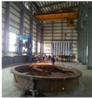
Thiết bị cho công trình thủy lợi
