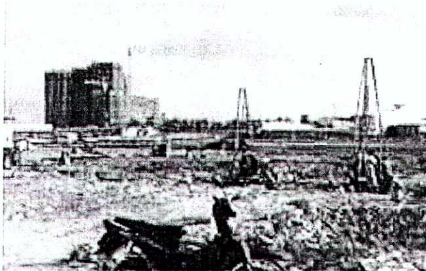
Khảo Sát Địa Chất Công Trình Saigon Pearl
