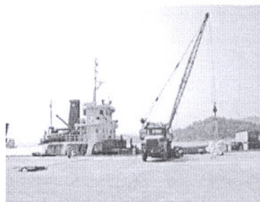
Xây dựng và sửa chữa công trình cảng
