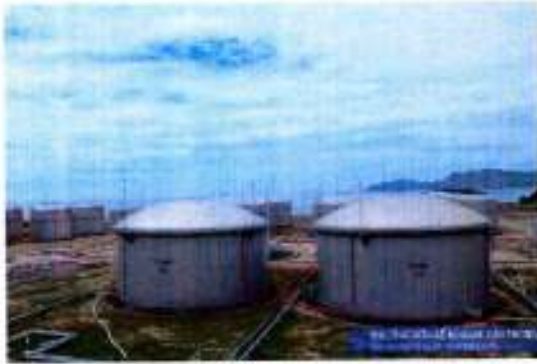
Thi công bồn bể 40.000 m 3 Vân Phong
