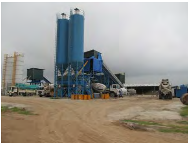
Trạm bê tông CN Eurotec-Italy: 05 trạm
