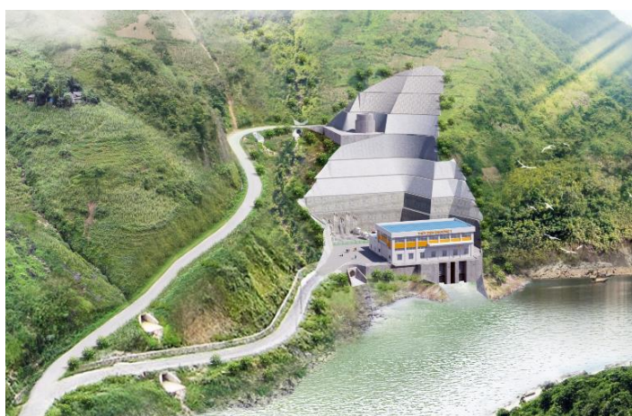
Toàn cảnh Nhà máy thủy điện Đa Krông 1
