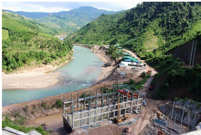
Nhà thầu đang thi công Nhà máy - kênh xả công trình thủy điện Đa Krông 1
