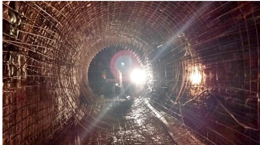
Nhà thầu đang thi công đường hầm áp lực công trình thủy điện Đa Krông 1
