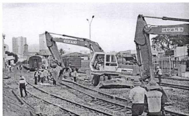
Sửa chữa đường sắt tại Ga Nha Trang – Khánh Hòa
