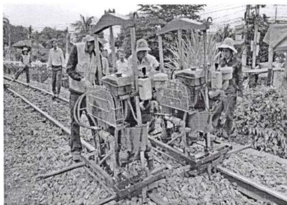
Sửa chữa đường sắt bằng Máy chèn Trung Quốc
