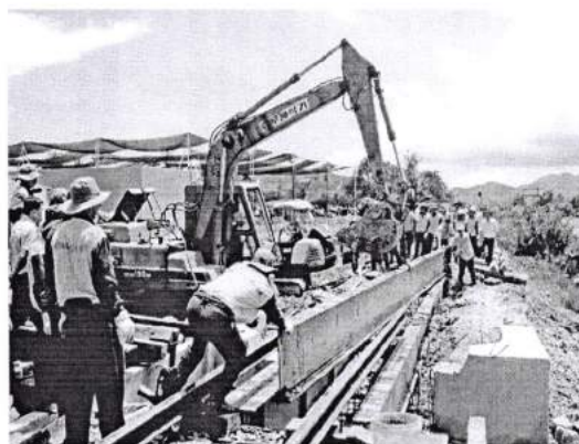
Sửa chữa lớn cầu Km 1280 trên tuyến đường sắt Hà Nội – TP. Hồ Chí Minh
