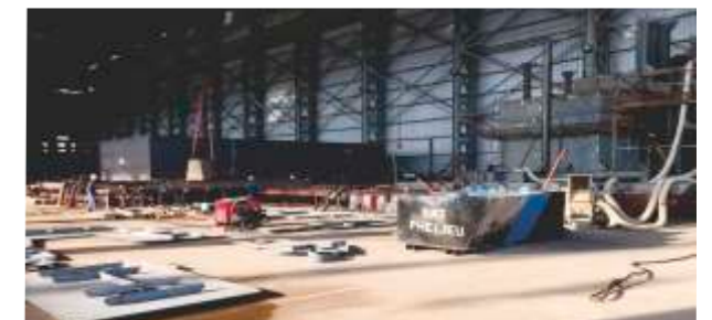
(Gia công chế tạo Block tại xưởng cơ khí)
