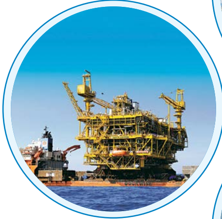
DỊCH VỤ CHẾ TẠO VÀ XÂY LẮP CÔNG TRÌNH DẦU KHÍ
