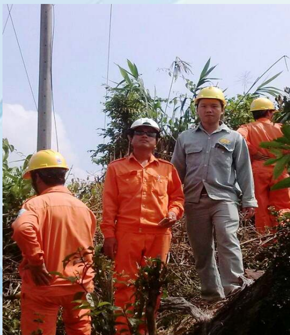
Kiểm tra và phát quang hành lang tuyến ĐZ 35kV
