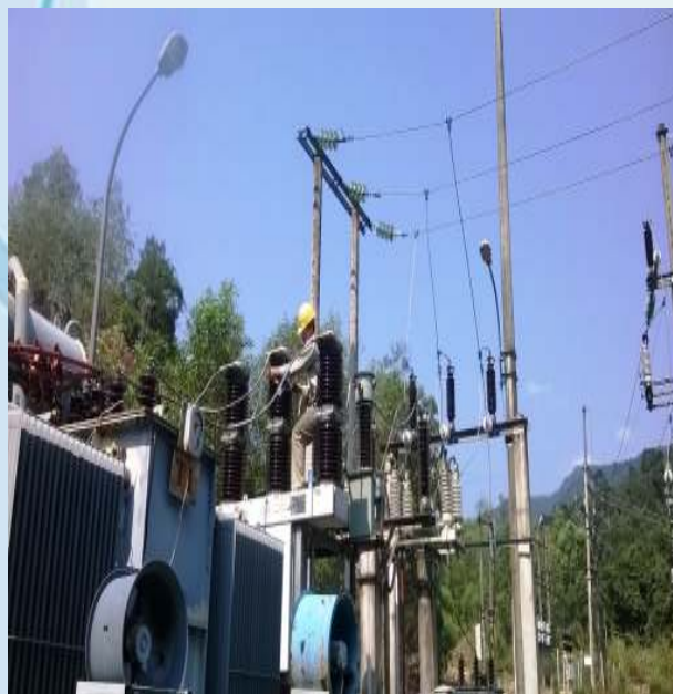
Đại tu thiết bị TBA 6,3/35kV
