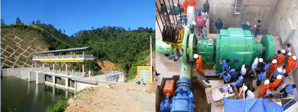
Hoàn thành công tác tư vấn thẩm tra và giám sát thi công phần thiết bị CTTĐ A Ròàng
