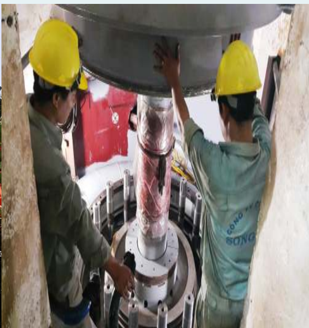
Sửa chữa đại tu tổ máy
