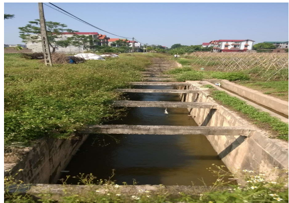
Hệ thống công trình thủy lợi huyện Mê Linh
