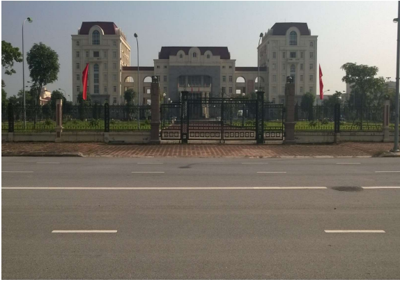
Xây dựng trụ sở, công trình phụ trợ huyện ủy – HĐND – UBND huyện Mê Linh
