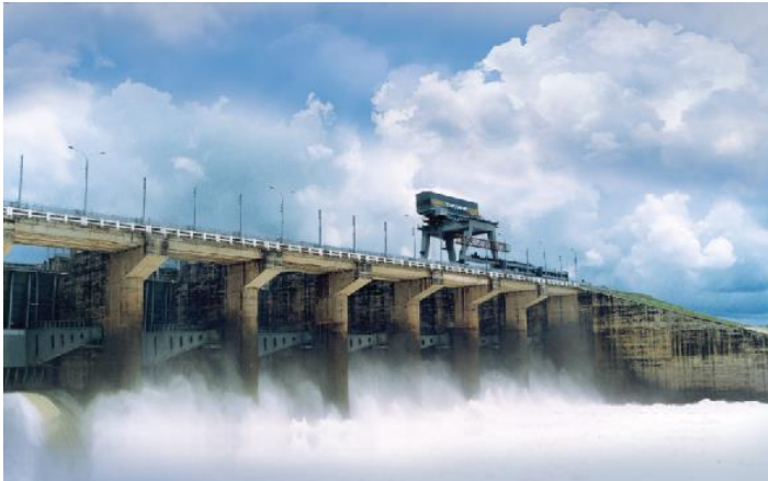
Nhà máy Thủy điện Trị An mở đầu cho thời kỳ phát triển nguồn điện phía Nam
