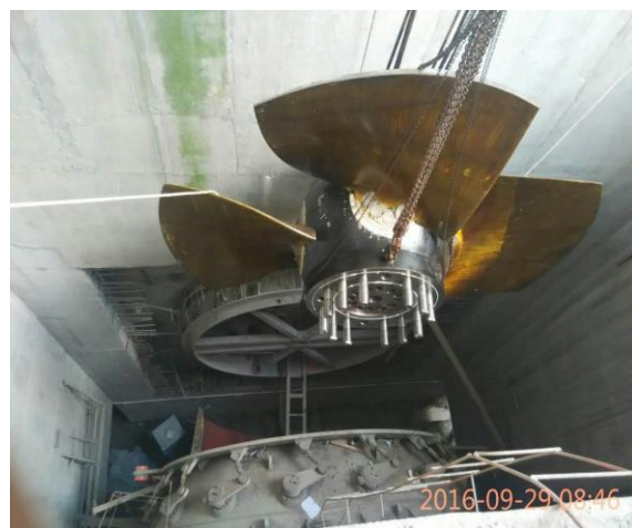
Hình 47: Quạt turbine của nhà máy thủy điện Bảo Lâm 1
