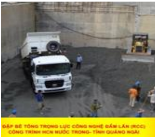
Hình ảnh thi công đập bê tông trọng lực RCC
