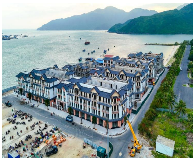
Hình 7: Hiện trạng dự án Vinpearl Phú Quý
